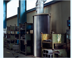
FRISCHLUFTZUFUHR DURCH DIFFUSOR
