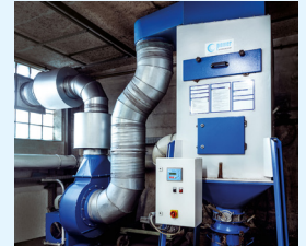
LA-VX 3600-7000 MIT NEBEN- STEHENDEM RADIALVENTILATOR
